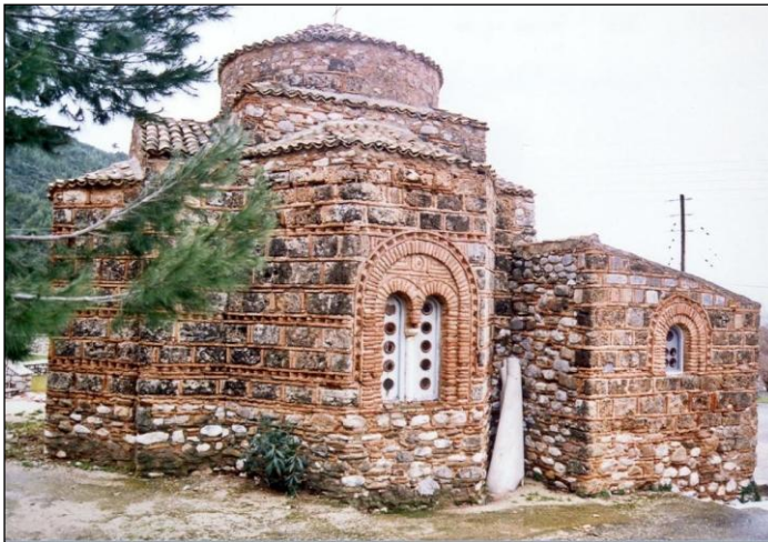
Β-Α άποψη Ι.Ν. Αγίου Νικολάου
